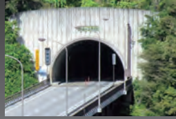
ウイング式 一般的なトンネルの坑門。
